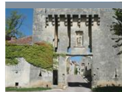
Autour du Ru de Vau
