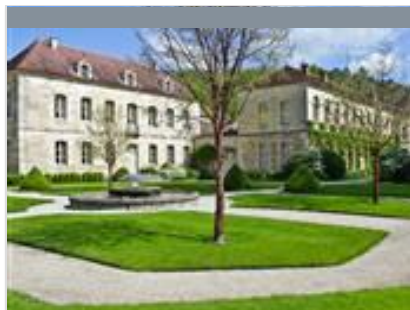
Vallon de Fontenay
