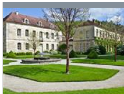
Vallon de Fontenay
